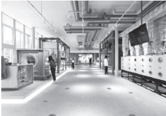
写真-1 ショールーム内観写真
