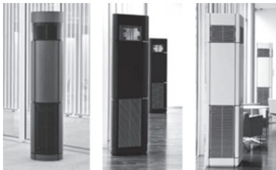
写真-3 各階形状の異なるポスト型ファンコイルユニット
