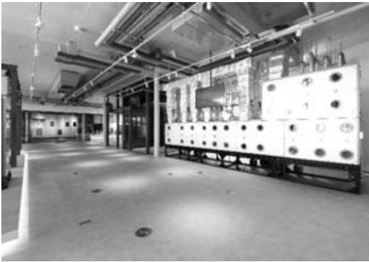
写真－4 体感ルームと専用空調機
